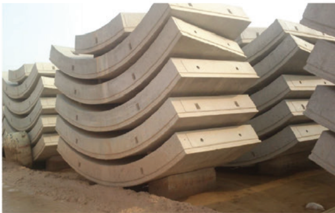
شکل ۳ - قطعات پیش‌ساخته در پروژه قطار شهری اهواز
