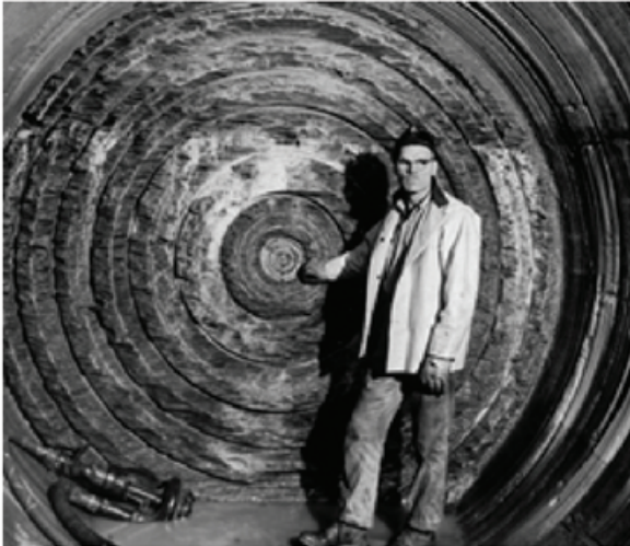
جیمز رابینز در کنار اولین جبهه کار حفر شده سنگ توسط TBM
